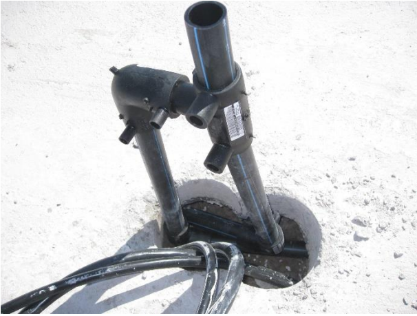
Kuvat: Valaisinpylvääseen tulevat vesi- ja sähköjohdot
