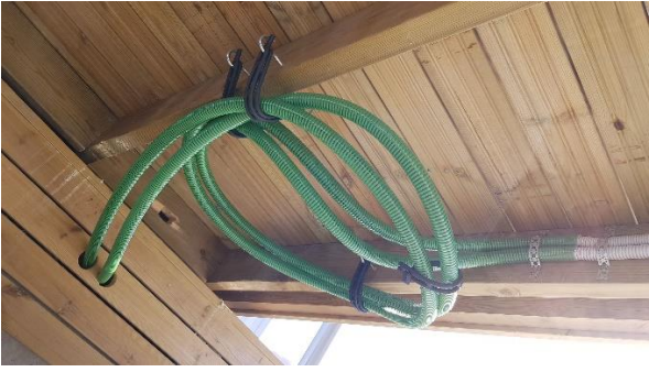
Kuva: Sähköputkien suojaus laiturin kannen alla liikkumisvaralla
